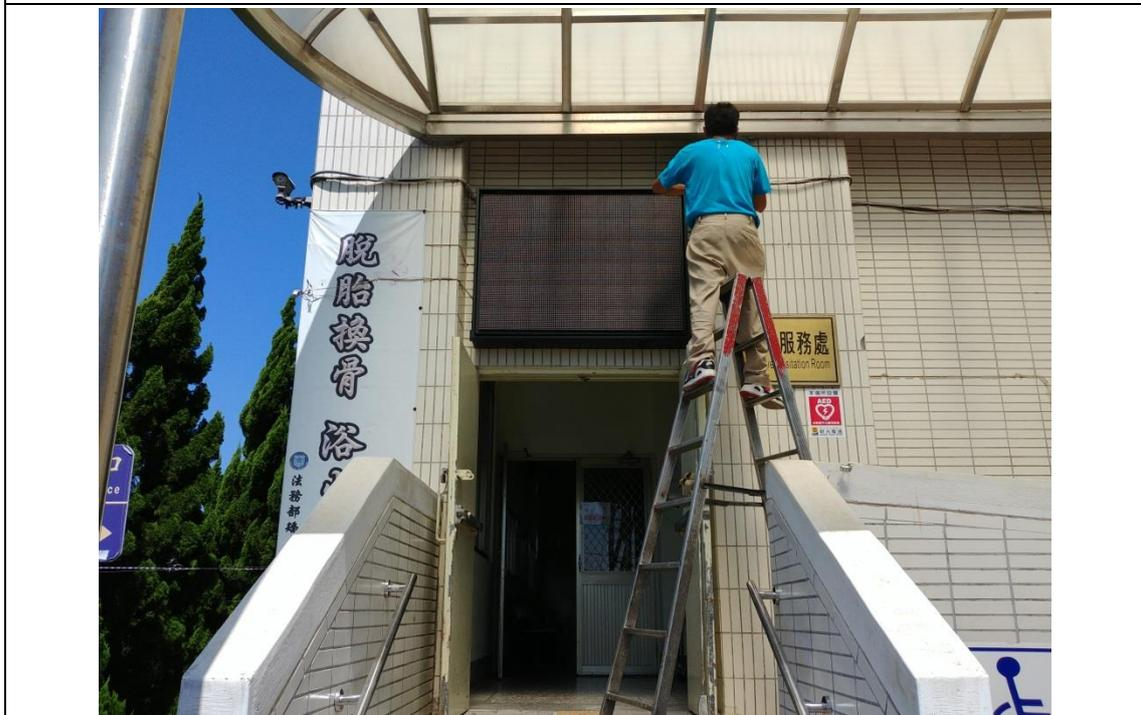
接見室入口 LED 字幕機安裝情形
