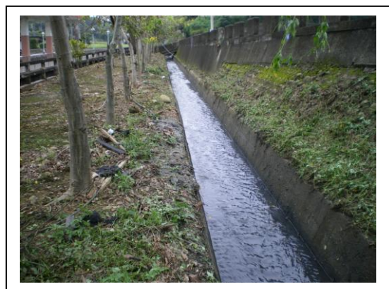
整治疏通後實景(由北向南拍攝)
