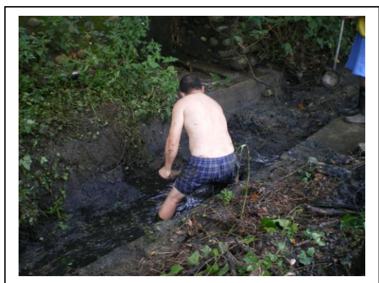
進入水溝進行淤泥、雜物挖除
