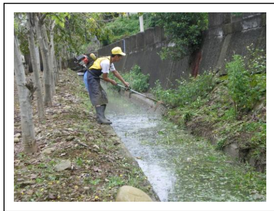
使用割草機割除水溝兩側雜草
