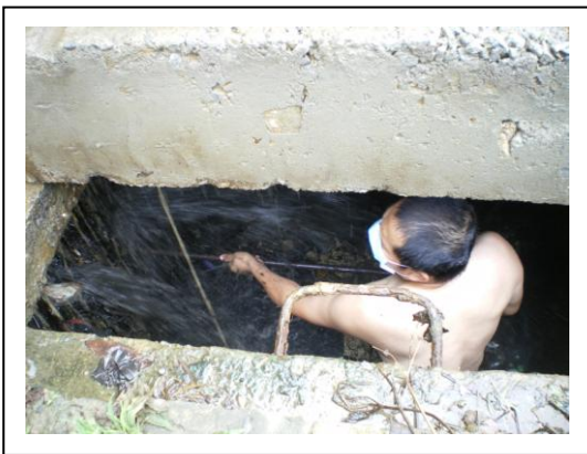
進入排水溝涵洞內清除阻塞物
