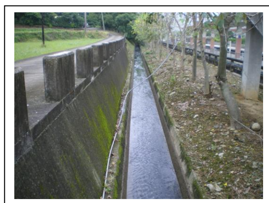
整治疏通後實景(由南向北拍攝)
