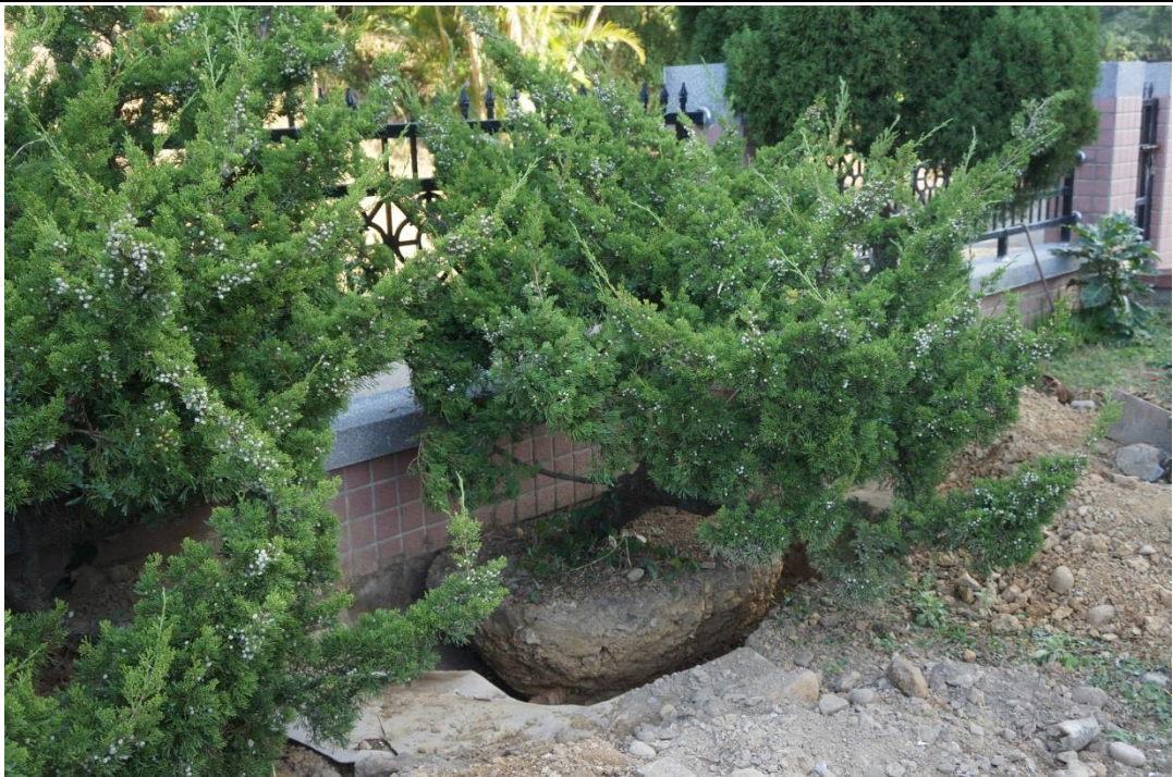
行政大樓右側圍牆內真柏移植土球開挖
